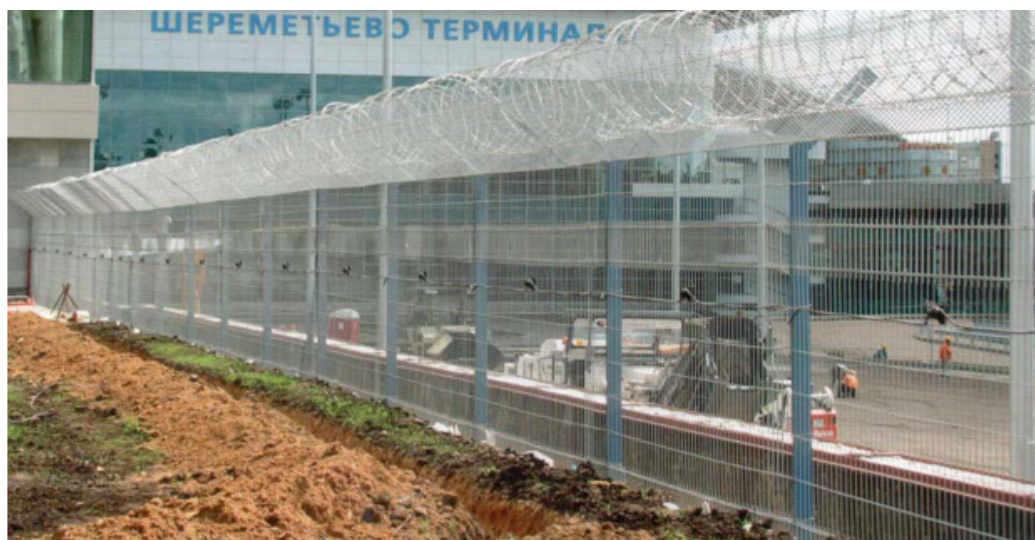
Рис. 2.5. Вариант усиления основного ограждения с секционным просматриваемым жестким полотном на железобетонном фундаменте без цоколя
