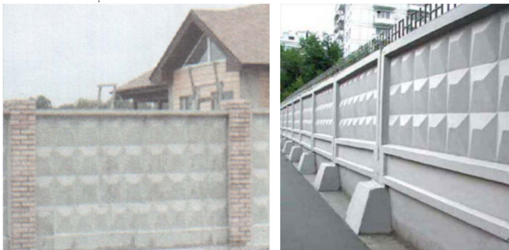
а) Ограждение железобетонное сборное
