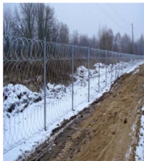
Рис. 2.2. Варианты основных ограждений с просматриваемым гибким полотном
