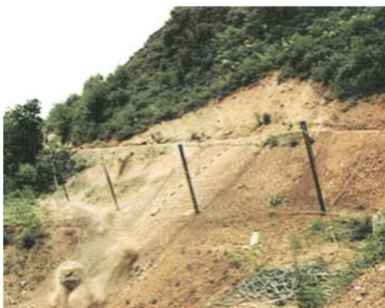
Рис. 2.19. Примеры конструктивных ПТЗ д) тросовые сети
